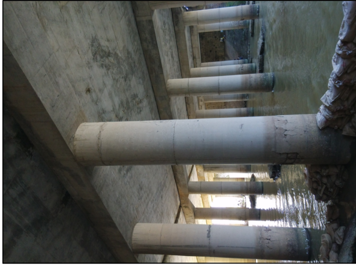
左4-3 墩存在明显纵向裂缝、钢筋外露且锈蚀严重
