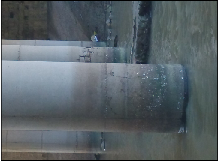
左3-3 墩混凝土开裂、脱落
