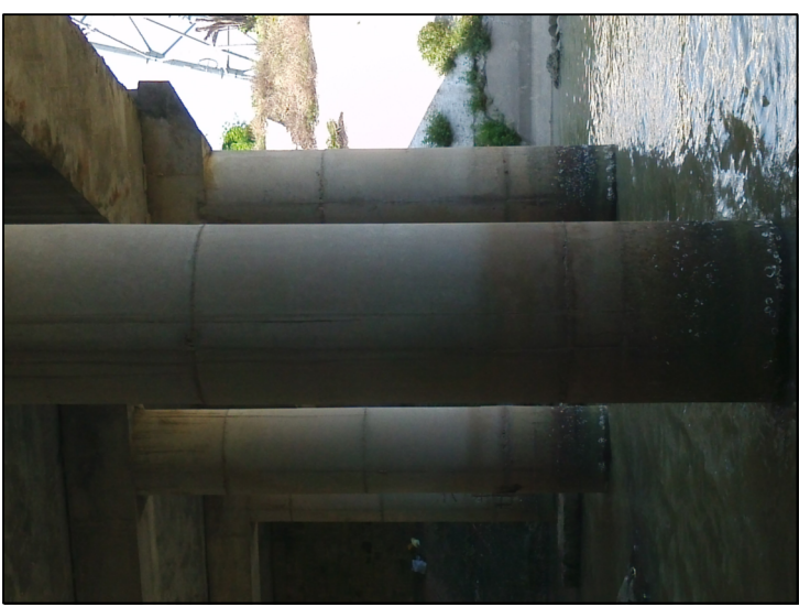
左3-4 墩表面混凝土腐蚀严重
