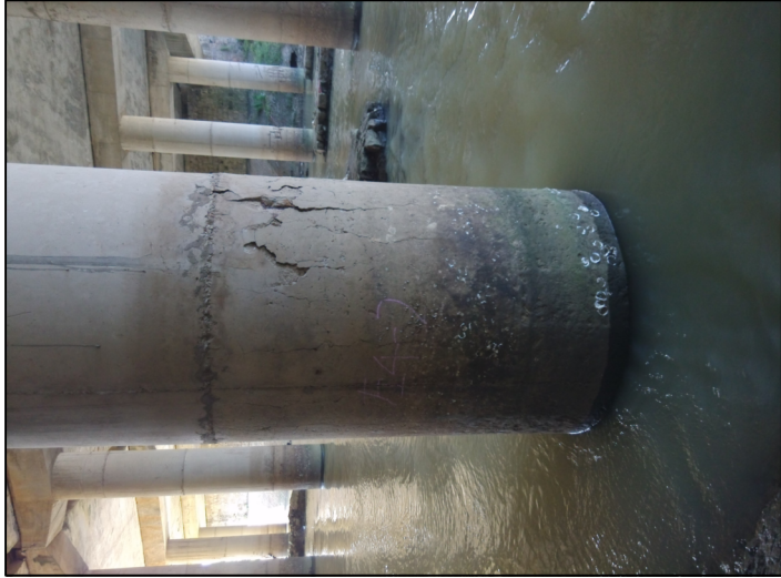
左4-2 墩混凝土开裂、脱落
