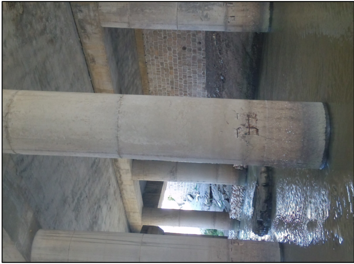
左3-2 墩混凝土开裂、脱落且钢筋外露且锈蚀严重
