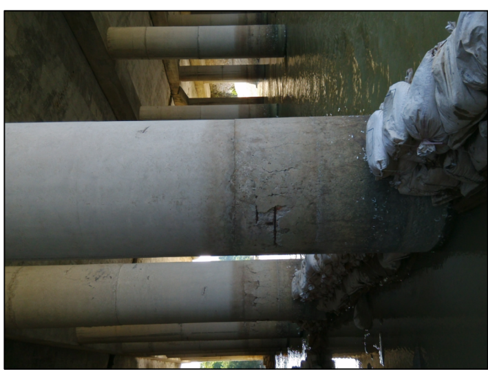
左4-4 墩混凝土开裂、脱落且钢筋外露且锈蚀严重
