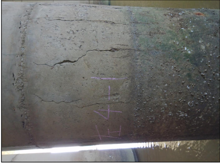
左4-1 墩存在明显纵向裂缝
