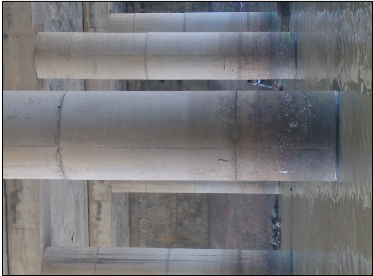
左3-1 墩表面混凝土腐蚀严重
